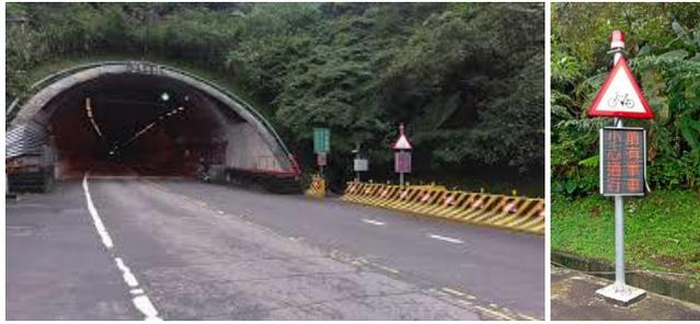
圖 1 台 2 線平雙隧道自行車智慧型警示系統
