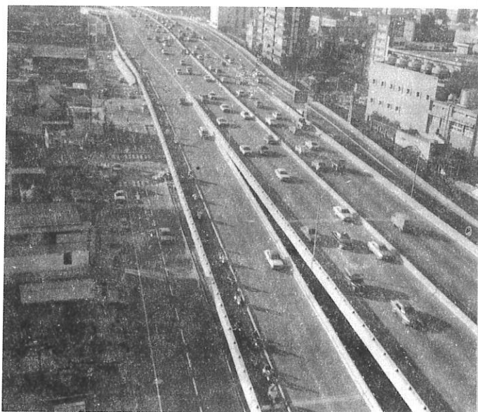
照片二 忠孝東路因匝道佈設不良即無車輛使用
