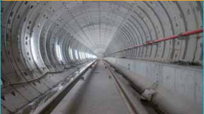
萬大線 CQ860 區段標工程
