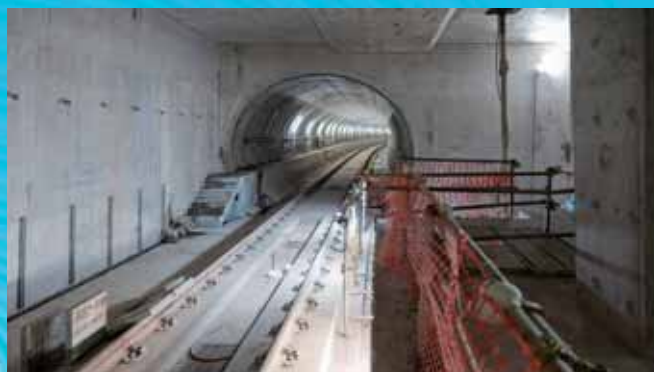
萬大線 CQ861 區段標工程
