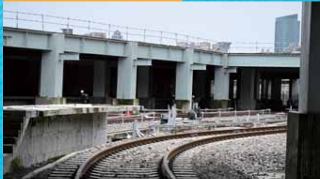
萬大線 CQ870 區段標工程
