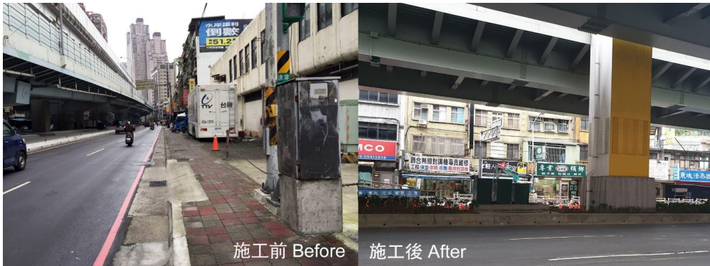
圖 2、人行道變電箱位置移動前後示意圖
