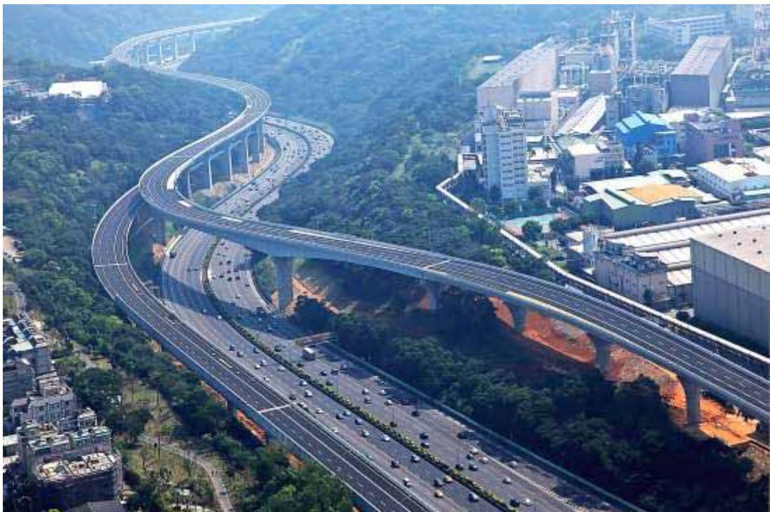
國道 1 號五楊拓寬工程通車已逾一年，對中山高五股至楊梅平面路段已達成預期分流及紓解的效果，這條主要服務中、長旅次的國道路段，為迴避地質及生態敏感區、降低對環境的影響，三座特殊鋼橋應運而生，國工局特將本路段最具特色的三座鋼橋，自橋型構想、分析設計到施工工法詳加介紹，編撰成「特殊橋梁技術專輯」。
